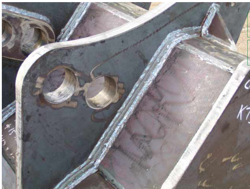
Dettaglio cordone di saldatura.
